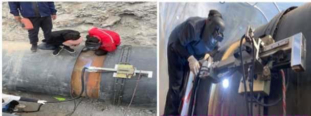
图 9 现场焊接 Fig. 9 On-site Welding
